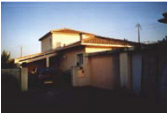
Surélévation partielle de maison individuelle, réalisée sur les murs porteurs existants
