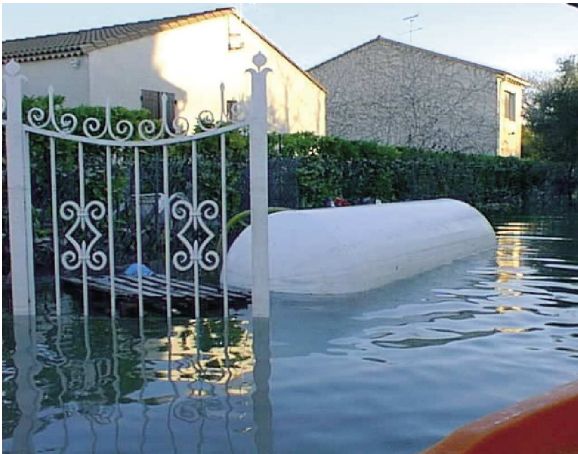
Cuve soulevée par l'eau Source : MEDD-DPPR - Inondations à Bellegarde - décembre 2003
