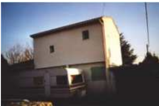
Surélévation réalisée sur une structure indépendante de la construction existante (piliers en béton armé extérieurs)
